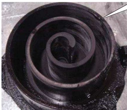
Rolamento do compressor em bom estado.
