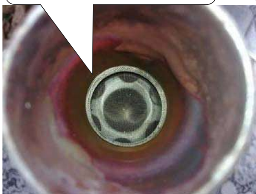
Filtro limpo (Tubulação de sucção do sistema).
